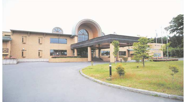
施設エントランス
